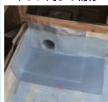
ドレン周りの補修
