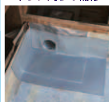
ドレン周りの補修
