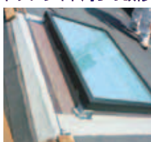
トップライト周りの改修
